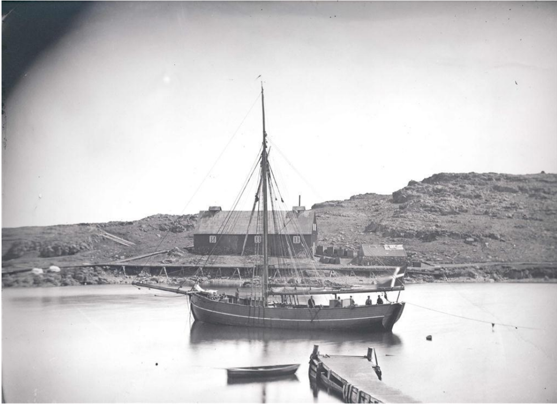
Smeltiríð ásamt steinhlöðnum skúr á athafnasvæði Ottos Chr. Hammer, suðaustan við voginn. Myndin er tekin nokkru eftir að hann hætti starfsemi 1871, en eftir það var lýsisbræðslan sennilega í eigu Örum & Wulffs. Lengst til vinstri mótar fyrir timbursliskjunnunni ofan að bryggjunni og rammert timburvirki heldur að uppfyllingu og aðgerðarplani framan við húsin. Í forgrunni sér ofan á bryggjuna framan við verslunarhús Örum & Wulffs. Úti á legunni er hugsanlega hákarlaskútan Bonnesen, sem Niels P. E. Weyvad verslunarstjóri átti og gerði út. (Ljósm. Nicoline Weyvad. Myndasafn Djúpavogshrepps. Frummynd Þjms. Th-22.)
