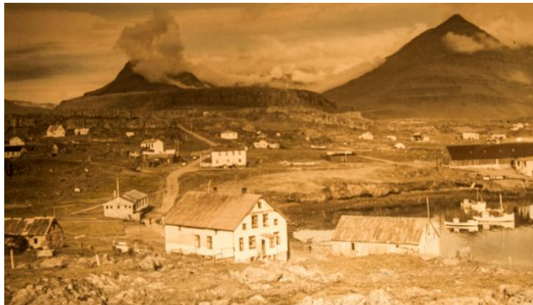
Séð vestur yfir byggðina af Bónдавörðuhrauni um 1945. Næst fyrir miðju er Framtíðin, Pakkhúsið til hægri og útihús til vinstri. Fjær er samkomuhúsið Neisti fyrir botni vogsins. (Ljósmynd. Ókunnur. Myndasafn Öldu Jónsdóttur.)
