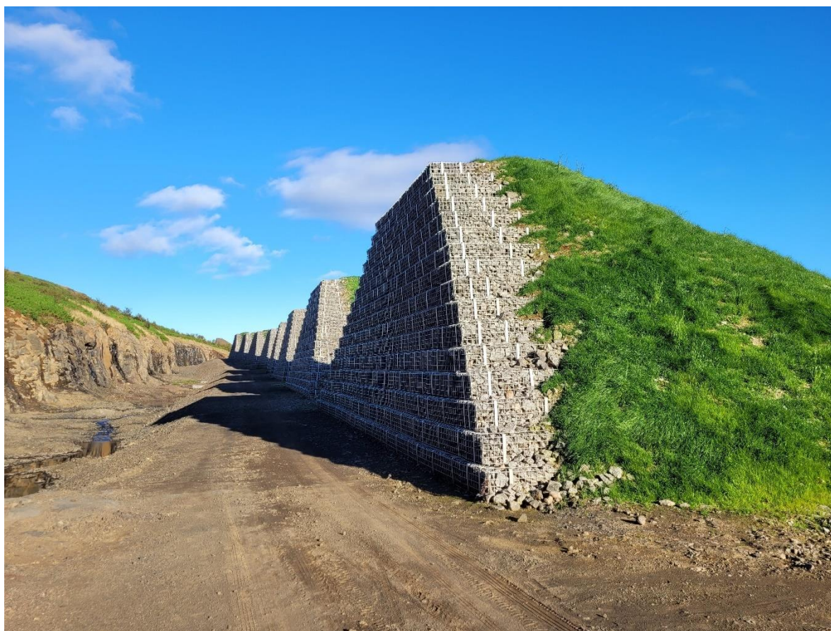
Mynd 5. Keilur undir Urðarbotnum og Sniðgili í Neskaupstað. Hæð keilnanna er 8 m, flóðhlið er brött og byggð upp með jarðvegsstyrkingakerfi úr stáli. Bakflái er um 1:1,8.
