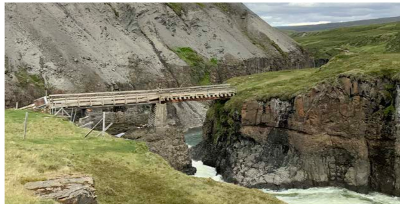
Mynd 2.10 Brú yfir Eyvindará nærri Stuðlagili.
