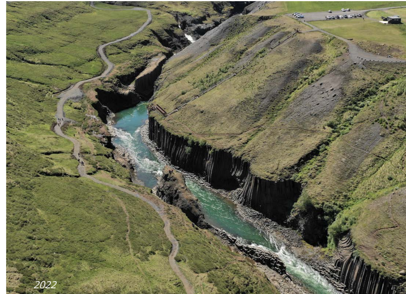
Mynd 3.6 Stuðlagil í júlí 2022. Það eykur á jarðvegsrofið á austurhliðinni að mikið vatn rennur niður úr hliðunum fyrir ofan gilið. Hluti þess vatns rennur eftir lækjarfarvegum og steypist niður ofan í árgilið. Annars staðar kemur vatnið upp á yfirborðið vegna þjöppunar á jarðvegi. Yfirborðið á blautum svæðum verður fljótt að moldarsvaði sem gestir eiga erfitt með að fóta sig eftir sem aftur stækkar svæðið sem umferð gesta nær yfir.
